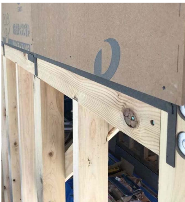
構造面材の継ぎ目にPEパッキン張り
