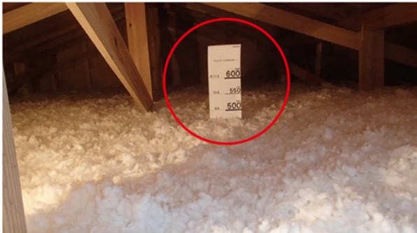
吹込み工法写真例
