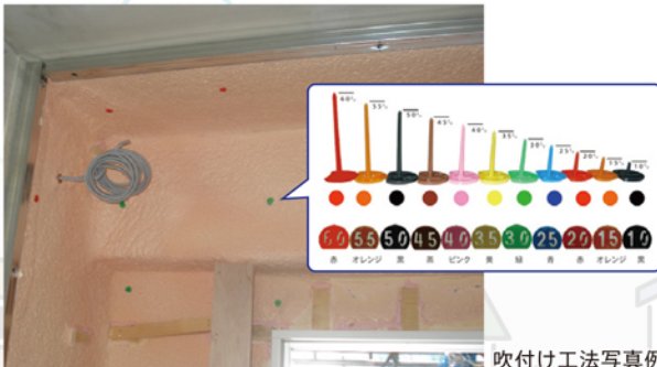
吹付け工法写真例
